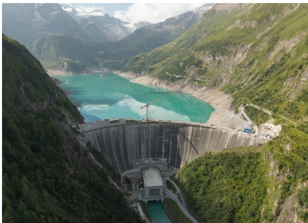
Mit der Staumauererhöhung wächst die Speicherkapazität des Wasserfallboden-Stausees um 30 GWh – genug Energie, um den Jahresbedarf von rund 6.000 zusätzlichen österreichischen Haushalten zu decken. © Doka
