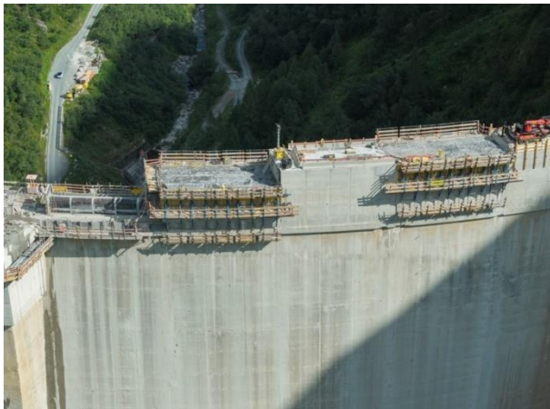
Mit der Sperrenschalung D22 und ergänzenden Systemen liefert Doka die Lösungen für präzise Betonagen im Hochgebirge. © Doka
