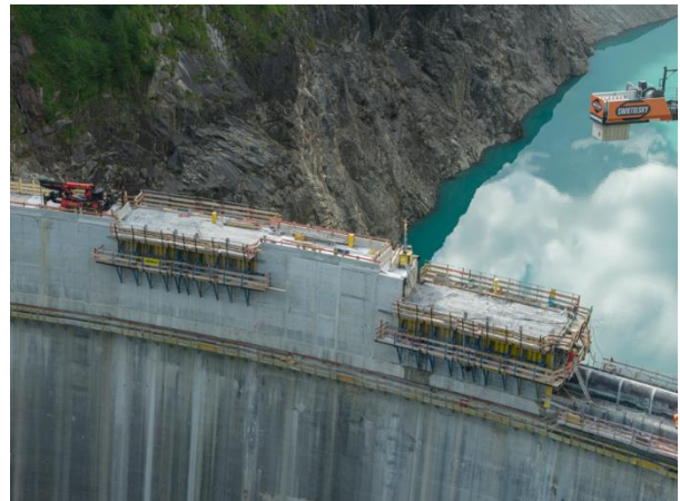
Mit der Sperrenschalung D22 und ergänzenden Systemen liefert Doka die Lösungen für präzise Betonagen im Hochgebirge. © Doka
