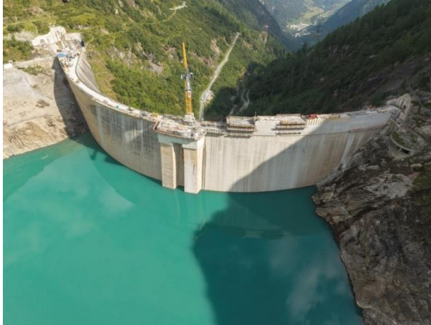
Die „Limbergsperre“ in Kaprun wird mit der Unterstützung von Doka um neun Meter erhöht. © Doka
